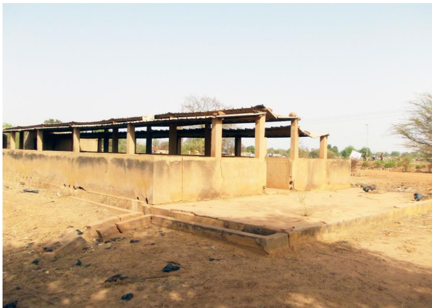
Figure 4. L'écurie, état existant.
