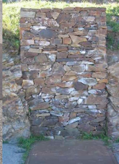
Figure 29. Le mur appareillé.
