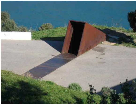
Figure 24. L'entrée du tunnel vue de côté.
