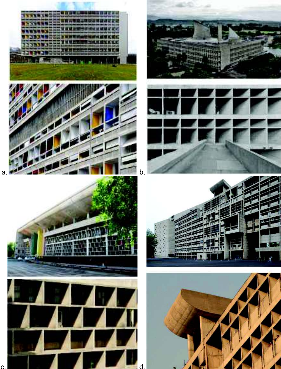
Fig. 2.3: a. Unité d'Habitation, Marsilia; b. Clădirea Parlamentului, Chandigarh ; c. Curtea de Justiție, Chandigarh; d. Scretariatul, Chandigarh [27]
