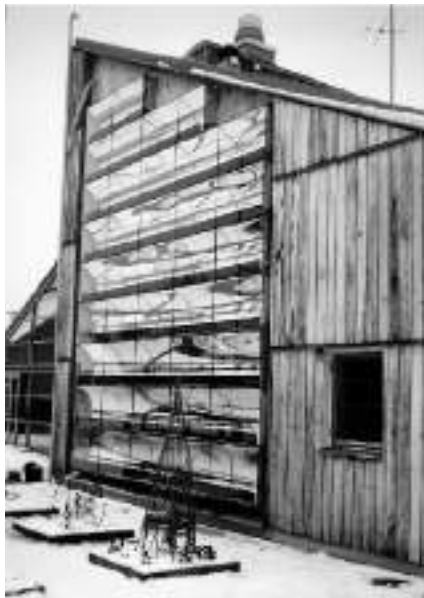
Fig. 2.8 – Fațadă care integrează colectori solari cu absorbție pe ambele fețe [23]
