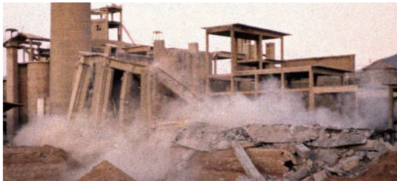
Figura 2.23 Demolarea parțială a structurii [44]
