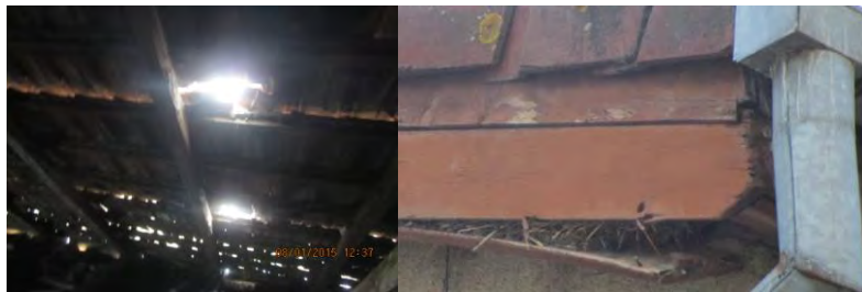
Figura 5.3 Elementele șarpantei avariate, Jgeaburi și burlane degradate, sparte
