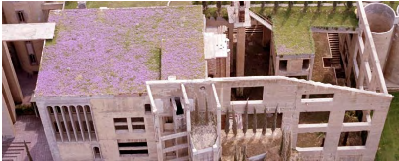
Figura 2.22 Acoperișul terasă necirculabilă [44]
