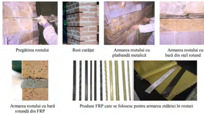
Figura 3.41 Bare/platbande metalice și din FRP introduse în rosturile orizontale ale zidăriei [9]
