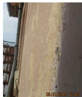
Figura 5.4 Tencuiala degradată
