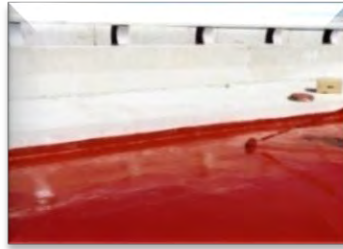
Figura 3.32 Membrana lichidă poliuretanică [20]
