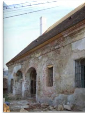
Figura 2.37 Vedere din exterior[53,54]
