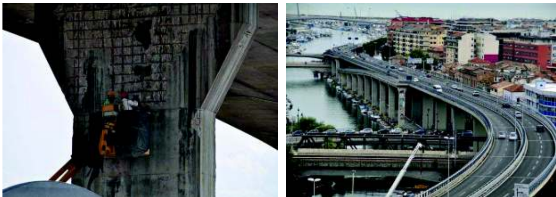
Figura 2.43 – Reabilitarea viaductului Valea lui Stan, 2014. Refacerea secțiunii din beton prin turnarea unui mortar de reparații structurale, Mapegrout Colabile GF armat cu fibre de oțel. Beton degradat de la baza stâlpului.
