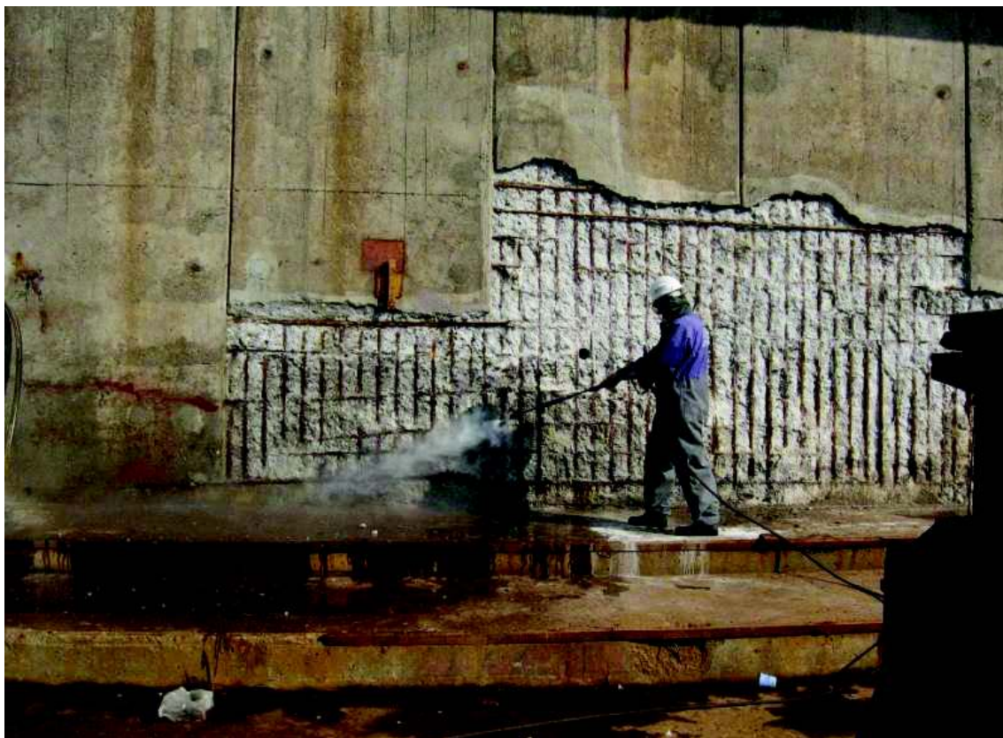
Figura 2.48 – Pregătirea suprafeței și aplicarea mortarului de reparații EuroCret® cu fibre rezistente la atac sulfatic, Daewoo Mangalia Heavy Industries.
