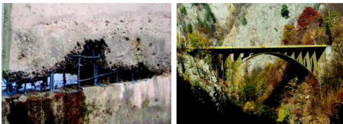
Figura 2.43 – Reabilitarea viaductului Valea lui Stan, 2014. Refacerea secțiunii din beton prin turnarea unui mortar de reparații structurale, Mapegrout Colabile GF armat cu fibre de oțel. Beton degradat de la baza stâlpului.
