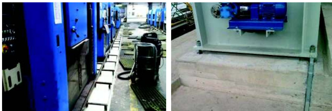
Figura 2.47 – Mortar armat cu fibre de oțel Pagel utilizat la lucrări de subturnare și ancorare la hale industriale.
