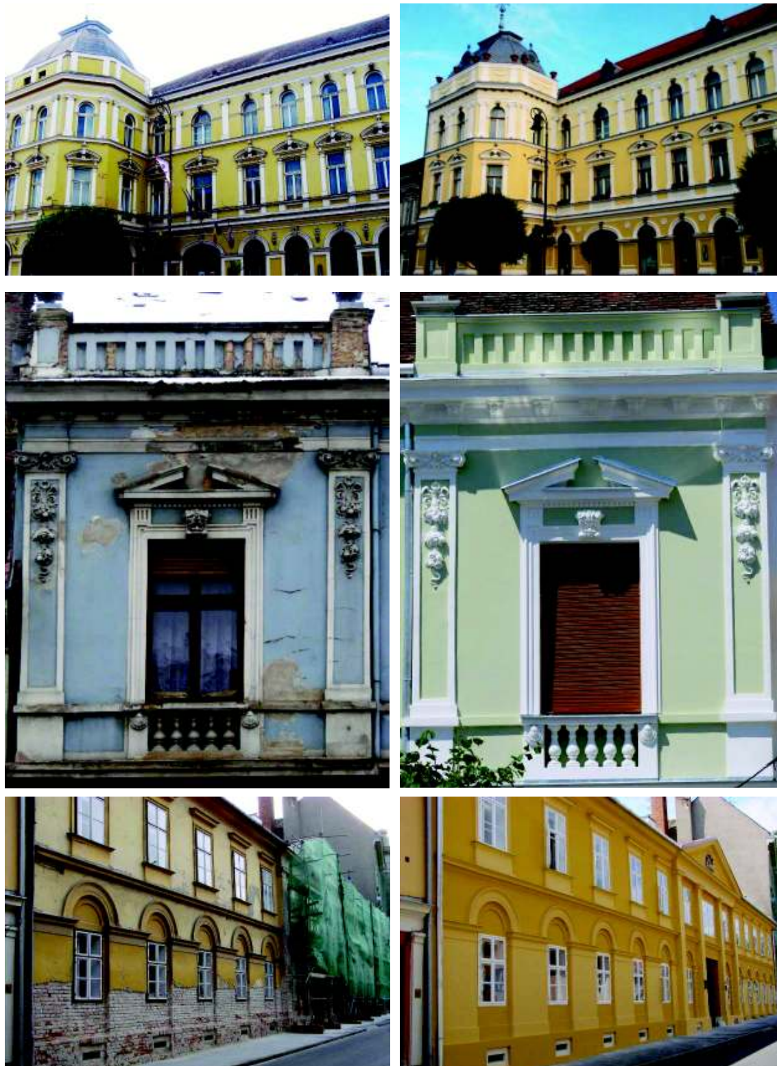
Figura 2.41 – Fațade reabilitate folosind mortare de tencuiei speciale armate cu fibre folosind mortar Lasselsberger-Knauf pe bază de var-ciment cu adaos de fibre, adecvat pentru renovarea tencuieiilor vechi [154]. Primăria orașului Sf. Gheorghe, România (primul caz) și fațade reabilitate în Ungaria (cazul doi și trei).
