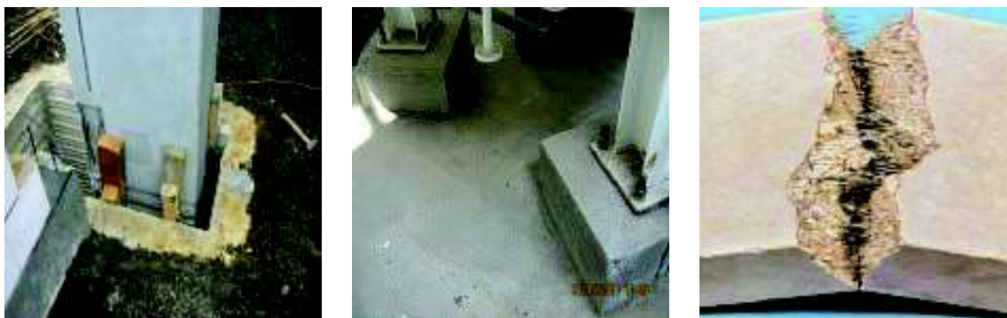
Figura 2.40 – Utilizarea mortarelor de sub-turnare armate cu fibre de oțel și aspectul compoziției acestuia.
