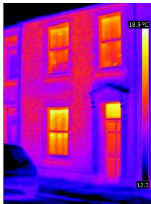
Fig. 2.7 Imagine termografică a fațadei unei clădiri [60]
