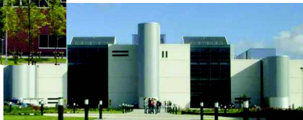
Fig. 2.12 Clădiri din sectorul nerezidențial realizate închideri din panouri de tip sandwich [70]
