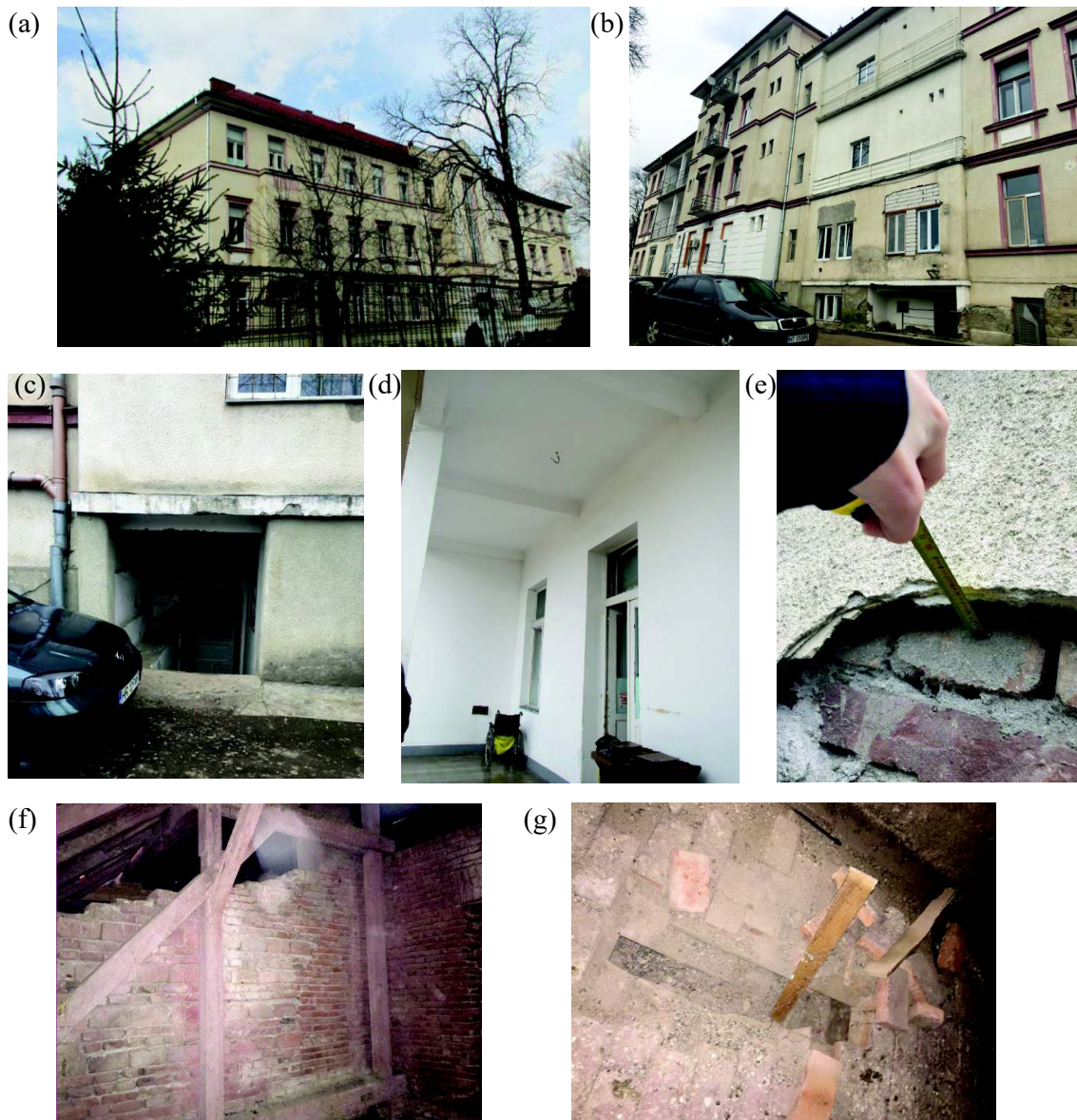
Fig. 6.44 Imagini ale clădirii 2 (a) Fațada SE – fațada principală; (b) Fațada NV; (c) Acces secundar, fațada NV; (d) Planșeu terasă circulabilă peste parter; (e) Tencuială exterioară, fațada SE; (f) Pereți spre spațiu neîncălzit (dinspre casa scării spre pod); (g) Stratificație planșeu de pod
