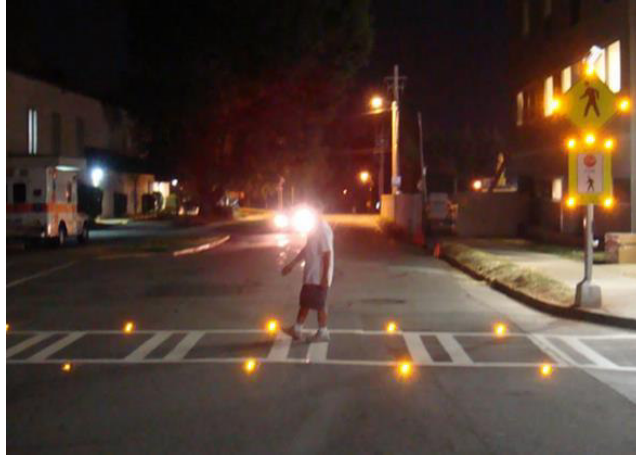
Figura 4.13. Trecere de pietoni cu butoni luminoși [30]
