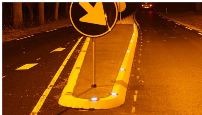
Figura 3.14. Insulă marcată și semnalizată cu butoni reflectorizanți
