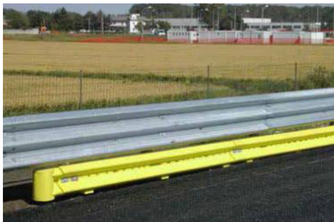
Figura 5 Element continuu pentru protecția motocicliștilor [FEMA,2012]
