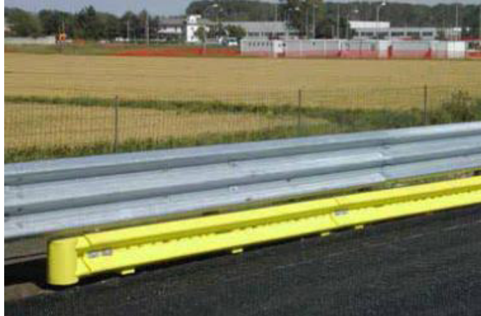
Figura 3.7. Element continuu pentru protecția motocicletilor [126]
