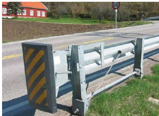
Figura 3.3. Capăt de parapet
