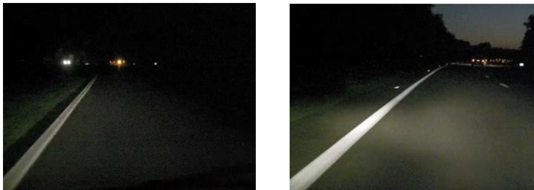
Figura 3.13. Sector de drum pe timp de noapte, fără și cu butoni reflectorizanți [sursa: Fijen International BV]
