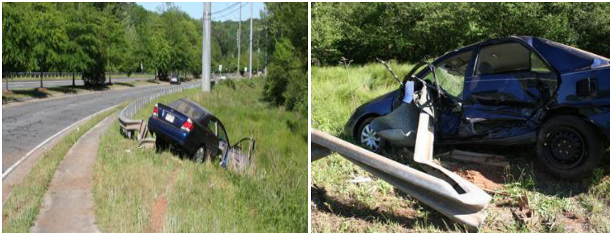
Figura 3.2. Capăt de parapet provocator de accident
