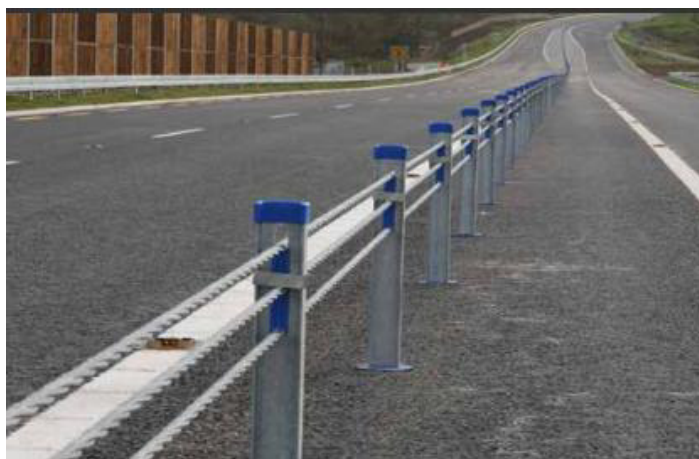
Figura 4 Barieră cu cablu [FEMA,2012]
