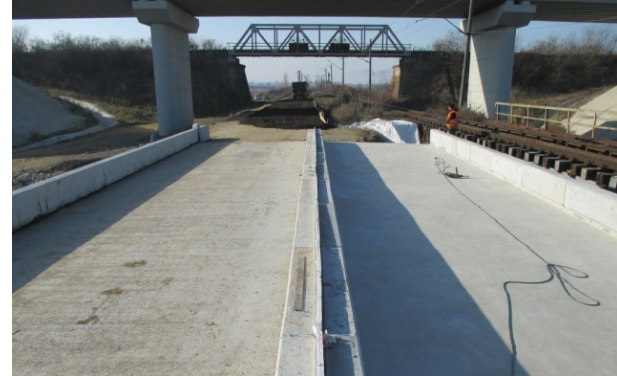
Pod în structură mixtă oțel-beton cu grinzi înglobate în beton Km 463+121(Simeria Veche) – Reabilitare CF Simeria – Vintu de Jos
