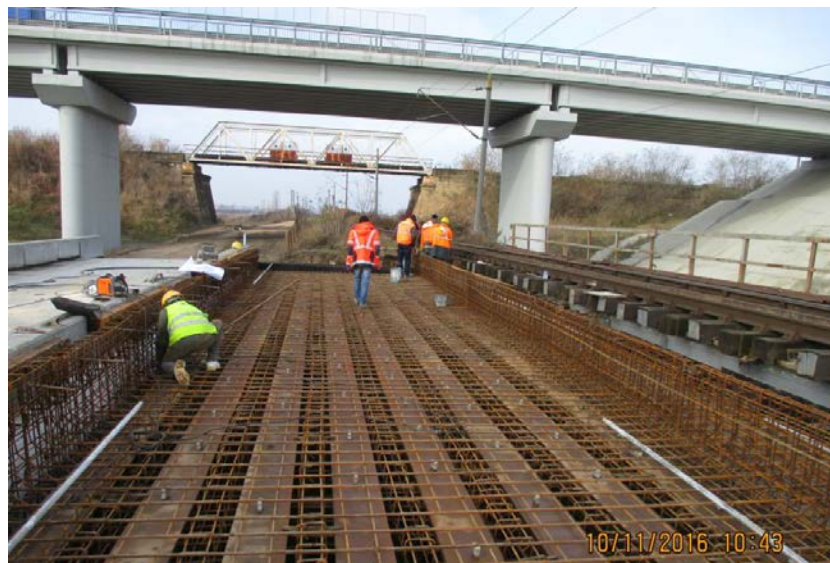
10/11/2016 10:43 Armare tablier fir I pod structura mixtă – grinzi înglobate în beton, km 463+121 – Simeria Veche Reabilitare CF Simeria – Vintu de Jos
