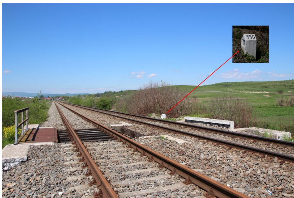
Fig. 5.2.-1. Podet dalat structură mixtă oțel-beton L.C.F. 300 Cluj-Napoca – Oradea, km 550+000
