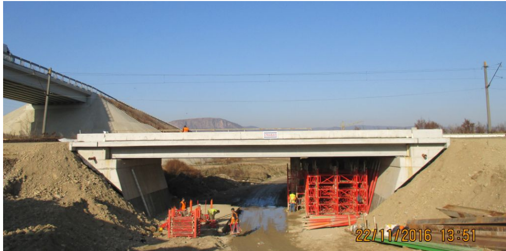
Pod structura mixtă – grinzi înglobate în beton, km 463+121 – Simeria Veche Reabilitare CF Simeria – Vintu de Jos
