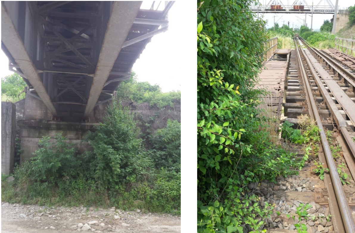
Tablier metalic nituit, grindă cu inimă plină, cale sus Km 463+121 Simeria Veche, Reabilitare CF Simeria – Vințu de Jos
