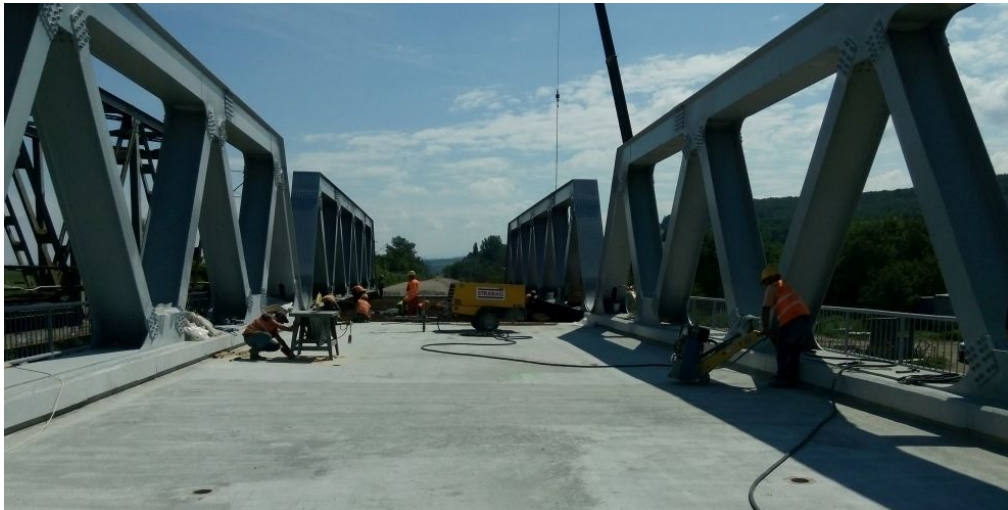
Pod peste râul Strei, km 462+841 – Simeria Veche Reabilitare CF Simeria – Vintu de Jos
