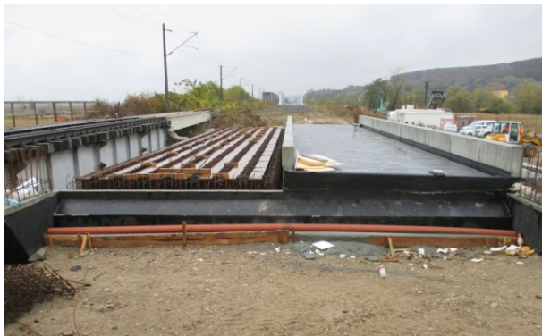
Pod în structură mixtă oțel-beton cu grinzi înglobate în beton Km 463+121(Simeria Veche) – Reabilitare CF Simeria – Vintu de Jos
