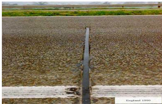
Fig. 3.3 Senzor piezoceramic (sursa imagine: [61])
