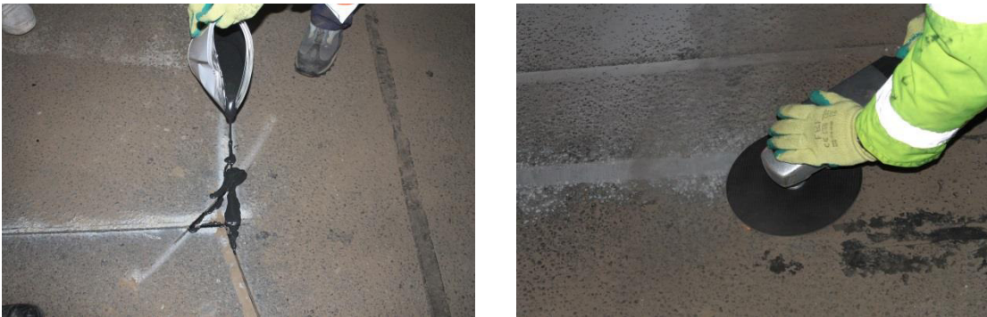
Fig. 3.48 Etapa 2: Colmatarea șlițurilor (stg.) și polizarea suprafeței de lucru (dr.)
