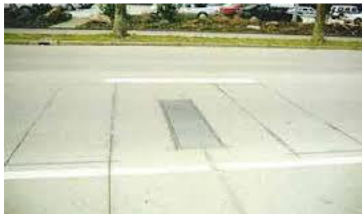
Fig. 3.33 Senzor de capacitate (sursa imagine: [61])
