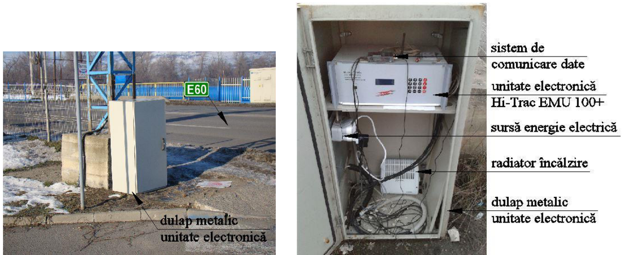
Fig. 3.41 Incintă protejată unitate electronică Hi-Trac EMU 100+
