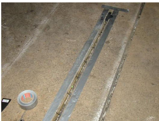
Fig. 3.44 Etapa 1: Pregătirea șlițurilor pentru instalarea senzorilor BL
