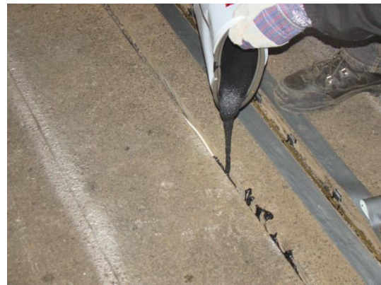
Fig. 3.45 Etapa 1: Amplasarea senzorilor și etanșizarea șlițurilor
