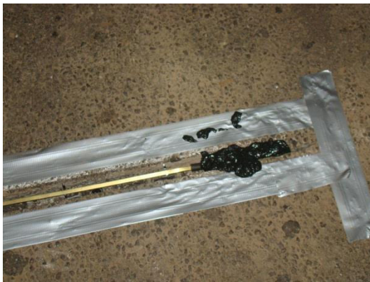
Fig. 3.45 Etapa 1: Amplasarea senzorilor și etanșizarea șlițurilor
