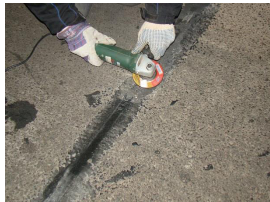
Fig. 3.46 Etapa 1: Finisarea suprafețelor
