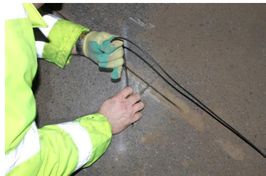
Fig. 3.47 Etapa 2: Tăierea șlițurilor (stg.) și instalarea cablurilor (dr.)
