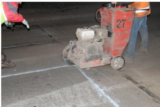
Fig. 3.47 Etapa 2: Tăierea șlițurilor (stg.) și instalarea cablurilor (dr.)
