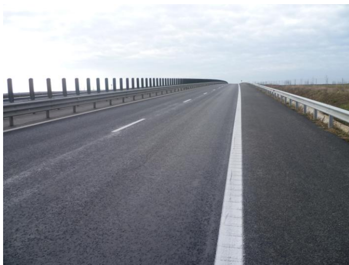
Figura 2 – Crearea unui efect de rampă pe un traseu de autostradă
