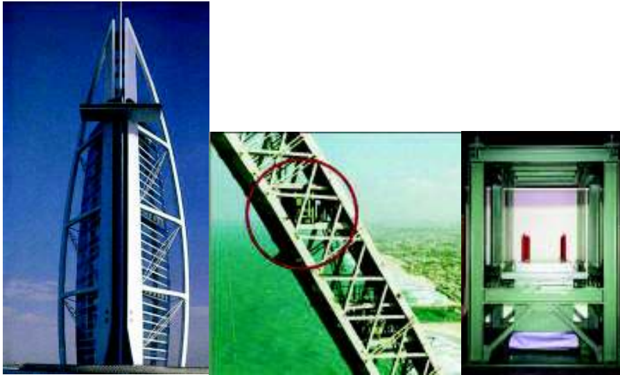
Fig. 1.4.7 Hotelul Burj al-Arab, Dubai și sistemul TMD [129]
