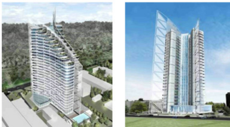
Fig. 2.33 Noul complex hotelier cu 27 de etaje din beton armat ridicat în Sochi (înălțime 93 m, suprafață locuibilă 40.000 m 2 ), protejat cu 156 izolatori tip LRB [31,96]
