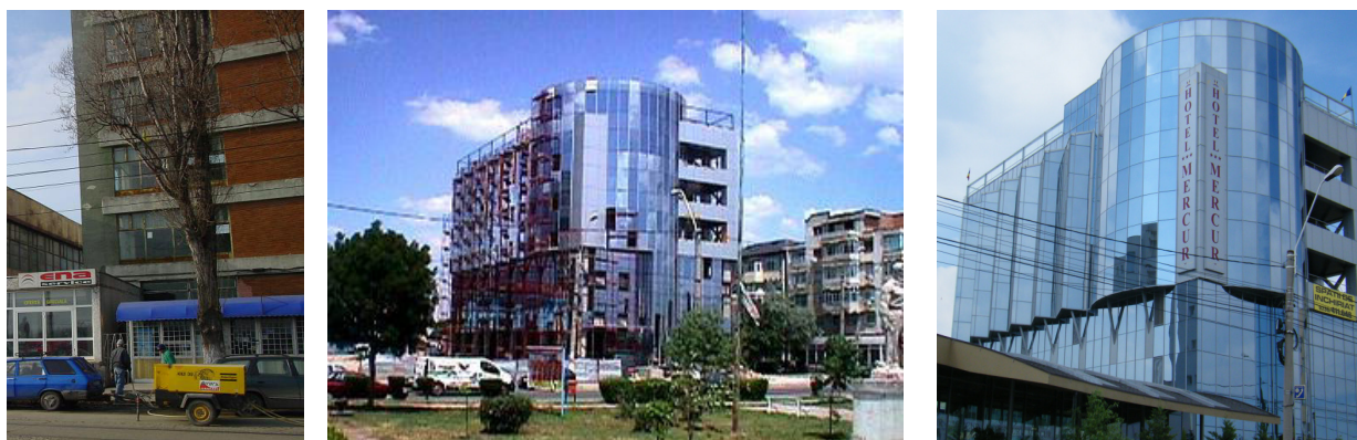
Fig. 2.17 Corp B NAVROM înainte de modernizare (stânga) și după modernizare (centru și dreapta) [161]
