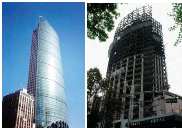
Fig. 2.4 Clădirea Torre Mayor, Mexico City [89]
