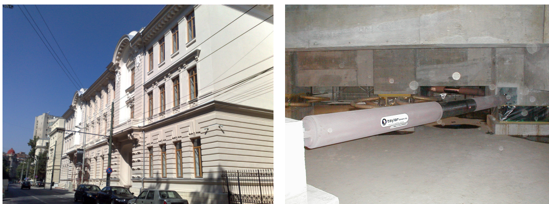
Fig. 2.5 Sediul Facultății de Management din cadrul Academiei de Științe Economice (stânga), Amortizor seismic Taylor Devices SUA montat în fundație (dreapta) [62, 64]
