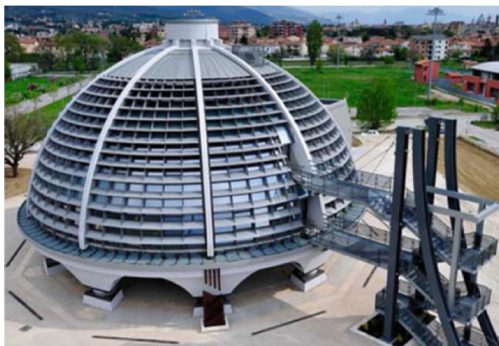
Fig. 2.29 Clădirea Centrului Civil de Apărare din Foligno (Italia) izolată seismic cu 10 izolatori HDRB [95]
