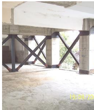
Fig. 2.20 Corp B – Detalii amplasare și prindere contravântuiri cu amortizori ȘERB [161]
