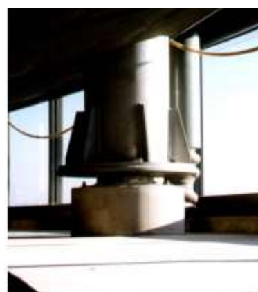
C- izolator orizontal cu frecare
