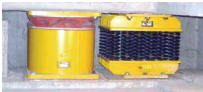
Fig. 2.36 Izolator de tip resort din oțel și amortizor vâscos [129]
