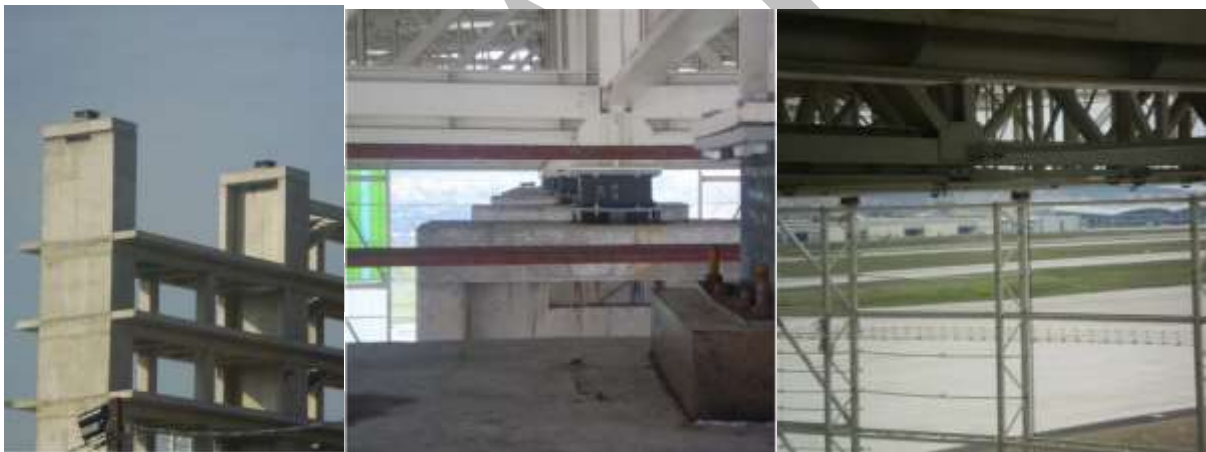
Fig. 3.16 Hangar Istanbul – Poziționare izolatori [61]
