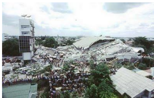
Figura 1.2 Colapsul hotelului Royal Plaza (Tailanda, 1993) [8]
