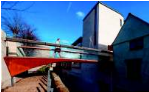
Fig. 3.29. Pasarela pietonală de la Colegiul Pembroke, Oxford, 2012
