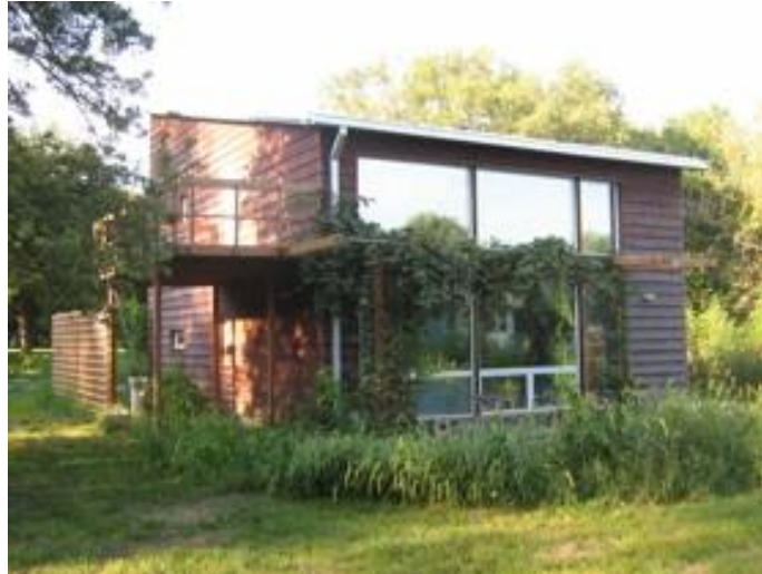
Figura 35. Casa Unifamilială. Urbana, Illinois, America de Nord, 2003
