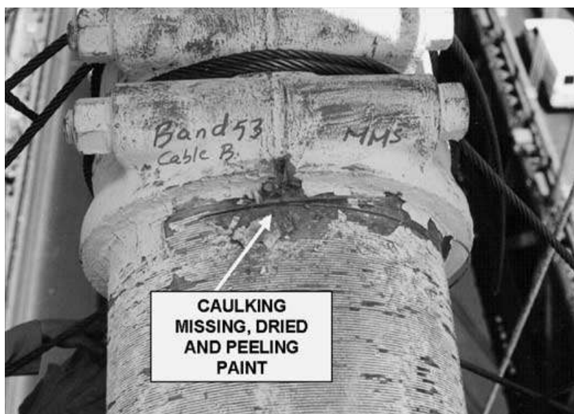
Figura 2.2. Crăpătură, vopsea uscată sau exfoliată [56].
