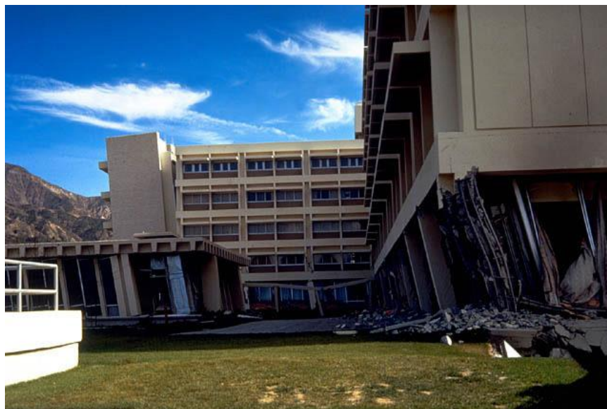
Fig. 2-5. Colapsul parțial al clădirii spitalului Olive View (mecanism de cedare de nivel), cutremurul din San Fernando 1971
