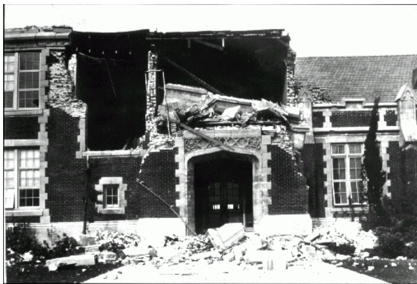
Fig. 2-2. Școală cu structură de zidărie avariata în timpul cutremurului din Long Beach, 1933 (sursa: http://www.ngdc.noaa.gov/hazard/icons/small_res/5/5_106.jpg , W.L. Huber)
