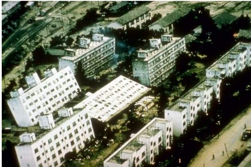
Fig. 2-4. Clădiri avariate din cauza lichefierii terenului, cutremurul din Niigata, Japonia, 1964 (sursa: http://www.ngdc.noaa.gov/hazard/icons/small_res/1/1_25.jpg )
