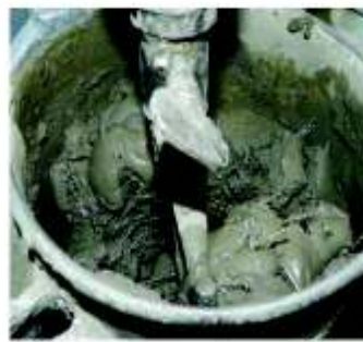
Malaxare amestec cu fibre
