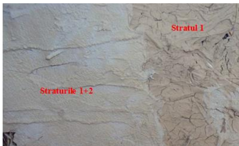
Fig. 5.33 Tencuială de argilă cu nisip aplicată peste primul strat de tencuială cu paie
