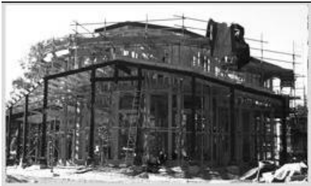
Fig. 3.4 Clădire cu două etaje, cu pereți din cărămizi de lut, Auckland-Noua Zeelandă [51]
