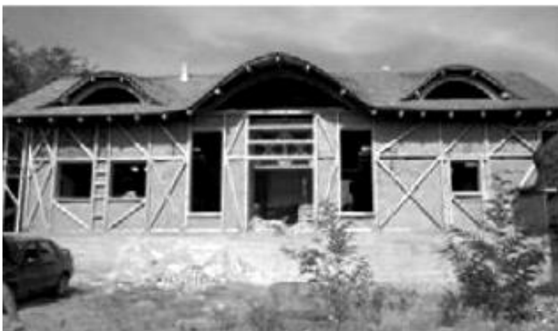
Fig. 2.16 Casa de vacanță, din baloți de paie, Valea Nucului, Buzău, Romania [18]
