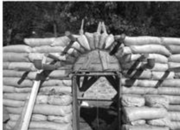
b. realizarea structurii prin stivuirea sacilor umpluți cu pământ bătătorit
