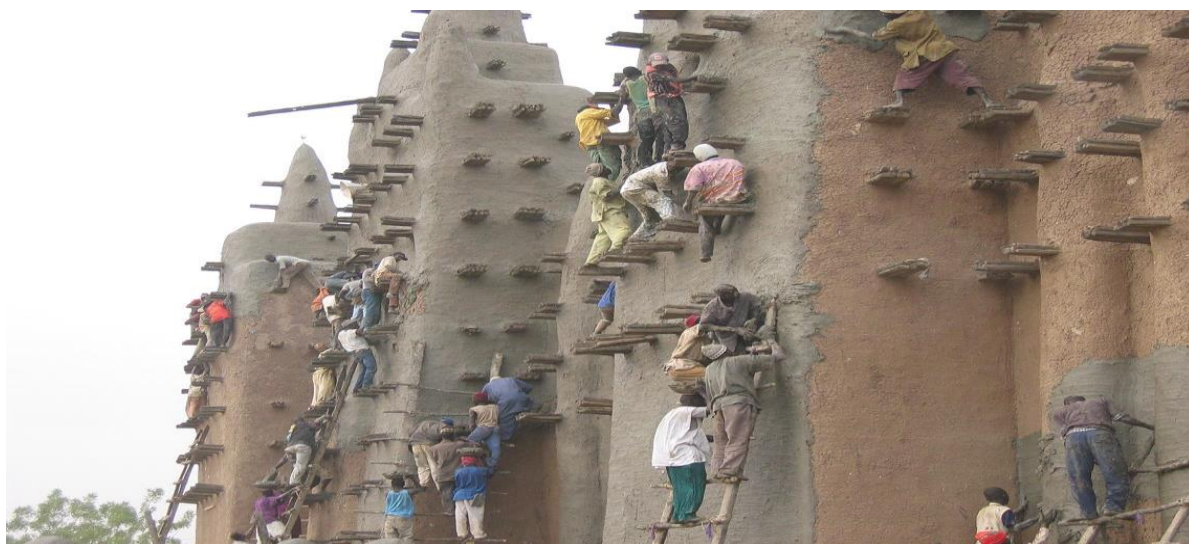
Fig. 2.18 Lucrări de întreținere la moschea Djenne, Mali[19]
