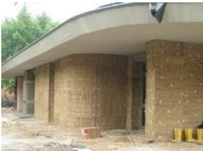
Fig 3.24. Izolarea cu pachete de stuf [113]
