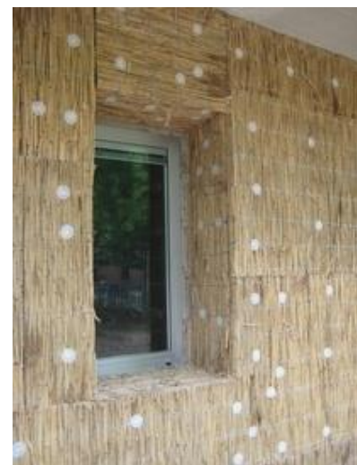
Fig 3.24. Izolarea cu pachete de stuf [113]
