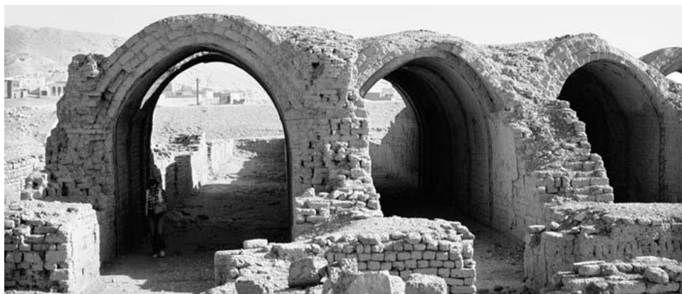
Fig. 2.4 Camere de depozitare în templul lui Ramses al II-lea, Egipt, construit din cărămizi de pământ acum 3200 de ani [7]
