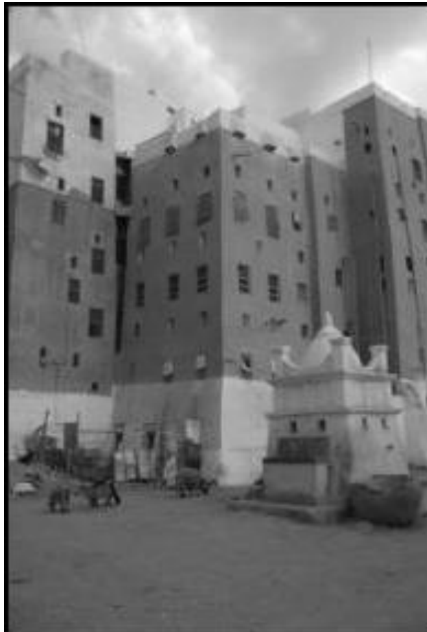
Fig. 2.8 Case de locuit din Yemen, realizate din cărămizi de lut și cob [12]
