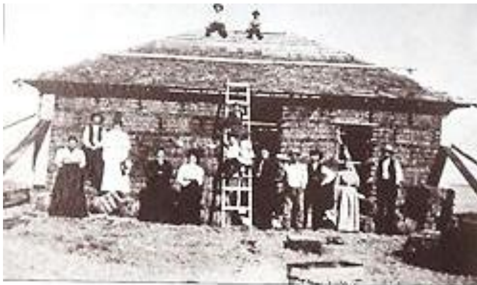
Fig. 2.11 Una din primele case din baloți de paie construite în sec. XIX [13]
