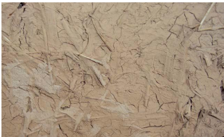
Fig. 5.31 Tencuială de argilă și nisip aplicată pe un balot de paie
