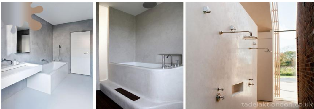
Fig. 3.27 Baie în stil marocan finisată cu Tadelakt [11]
