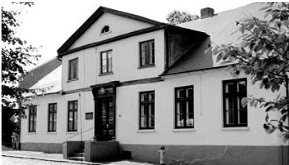
Fig. 2.9 Casa cu pereți umpluți cu pământ, Germania, 1795 [12]
