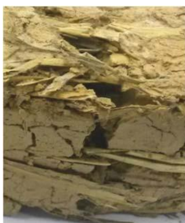
b. detaliu zona fisurare
