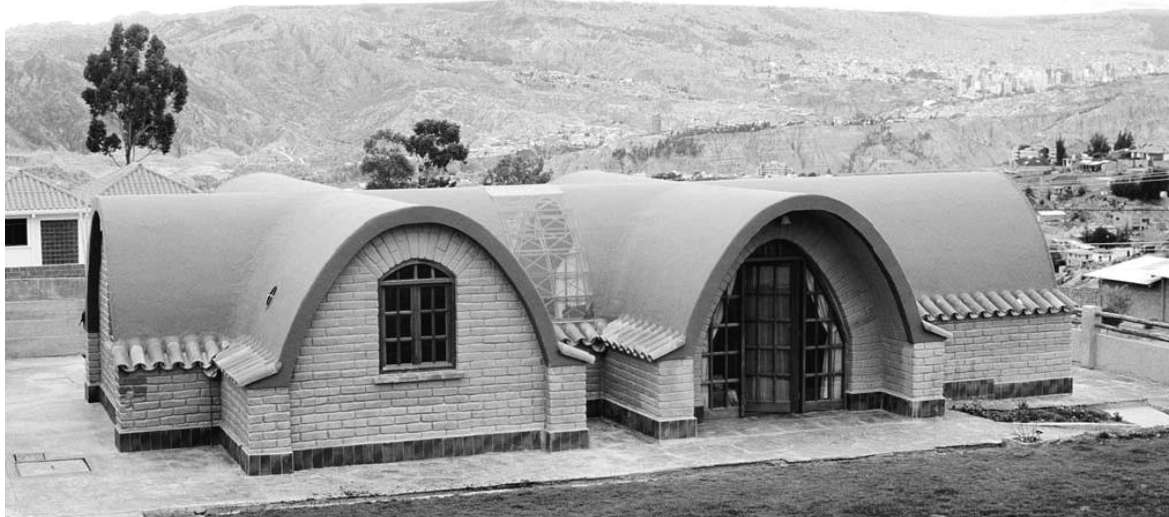
Fig. 2.15 Casa cu pereți și acoperiș tip cupola, din cărămizi de lut, La Paz, Bolivia [17]
