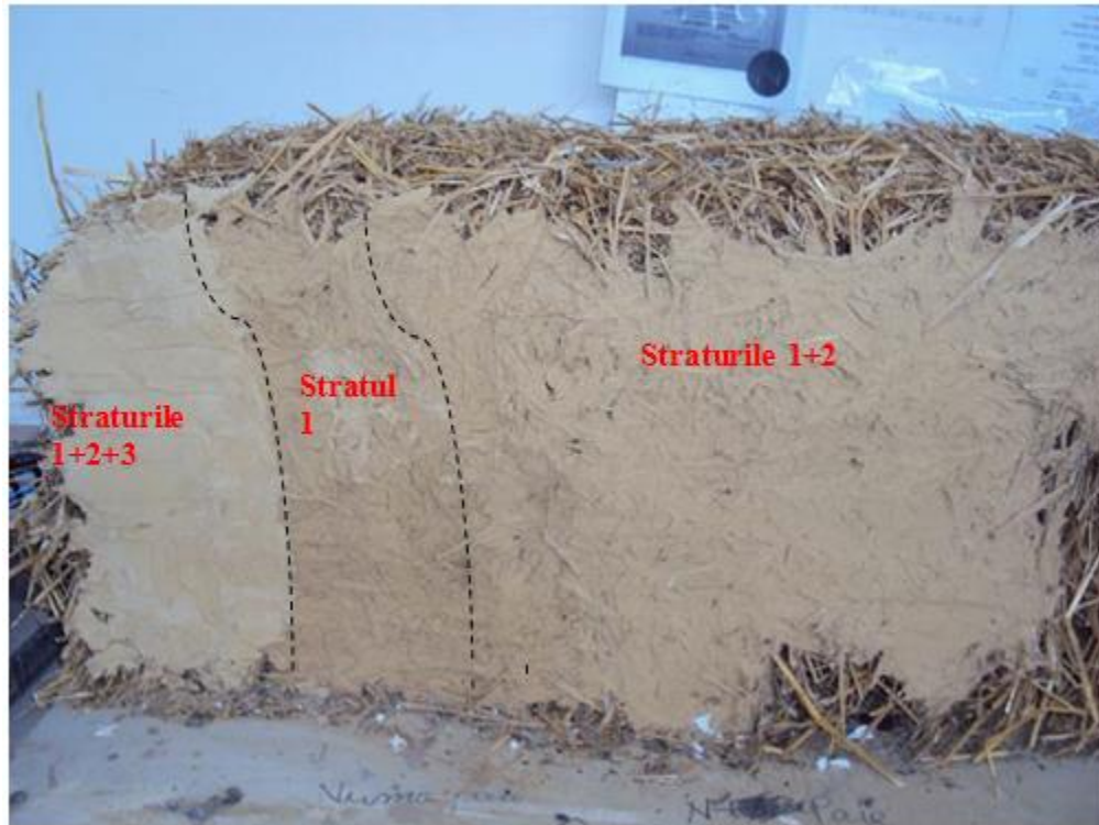
Fig. 5.34 Straturile de mortar aplicate pe balotul de paie
