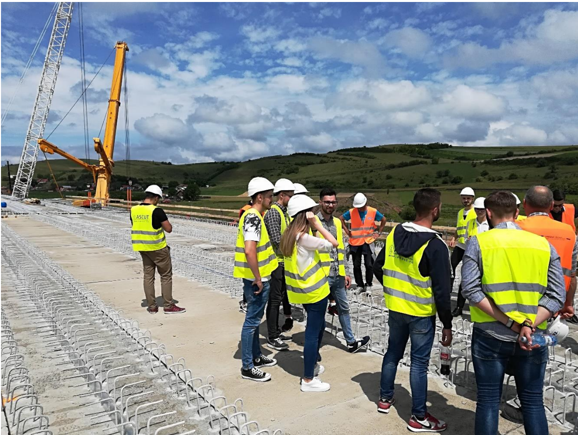
15 Iunie 2018 – Vizita tehnica cu studenții șantier Autostrada A3 Gilău – Mihăiești
