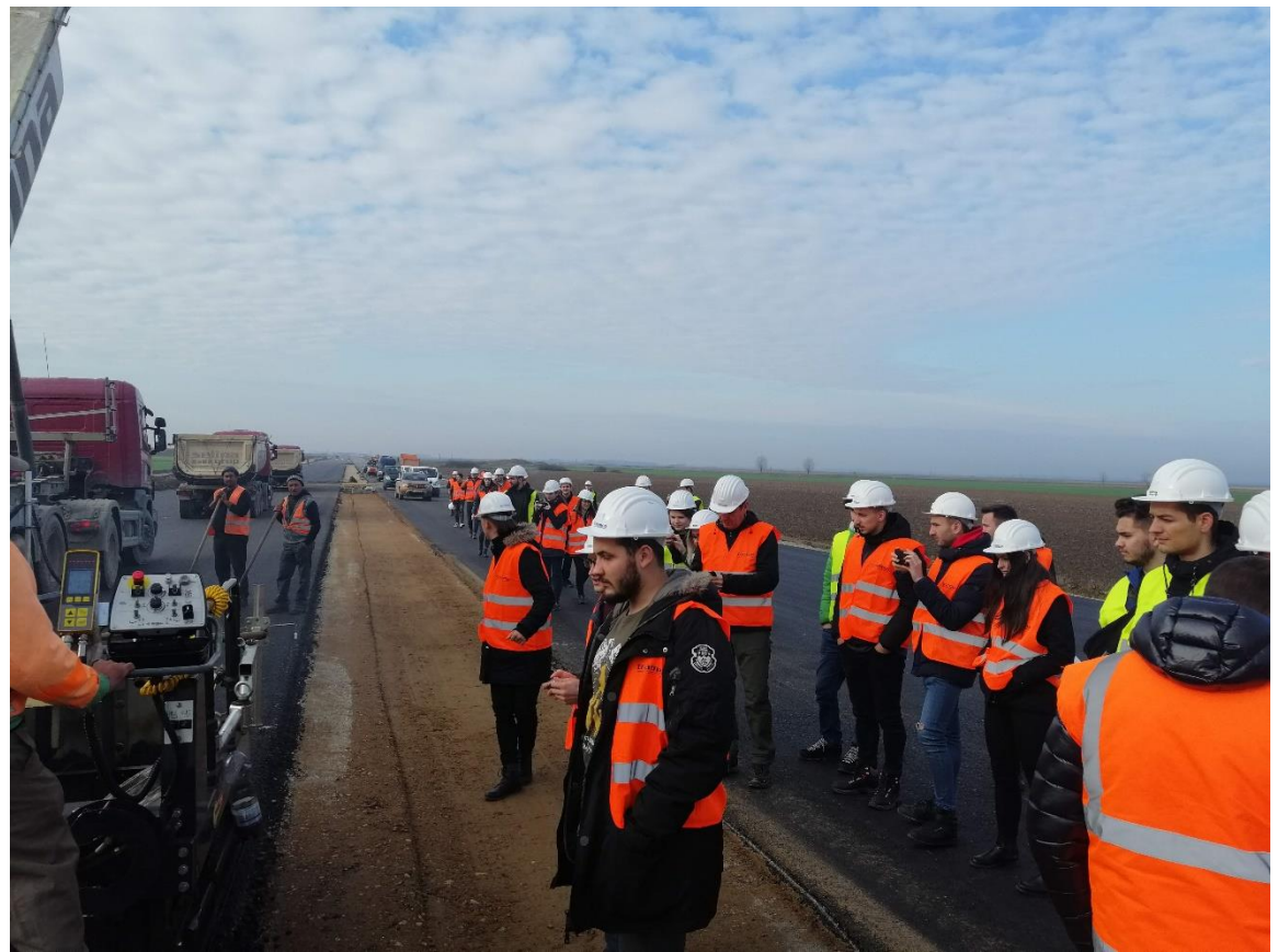
26 Noiembrie 2019 – Vizita tehnica cu studenții șantier Autostrada A3 – Sector Borș - Biharia
