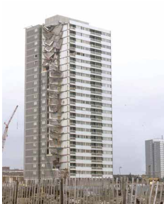
Fig. 1.1. Clădirea de apartamente Ronan Point, Canning Town, Anglia [6]
