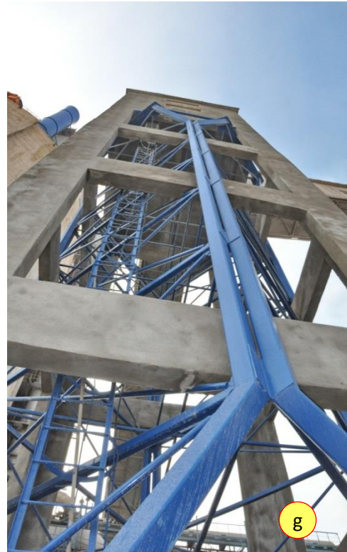
Foto 1.18. Turnul de întoarcere de la complexul industrial Azomureș, Tg. Mureș: situația după consolidare (f-j)
