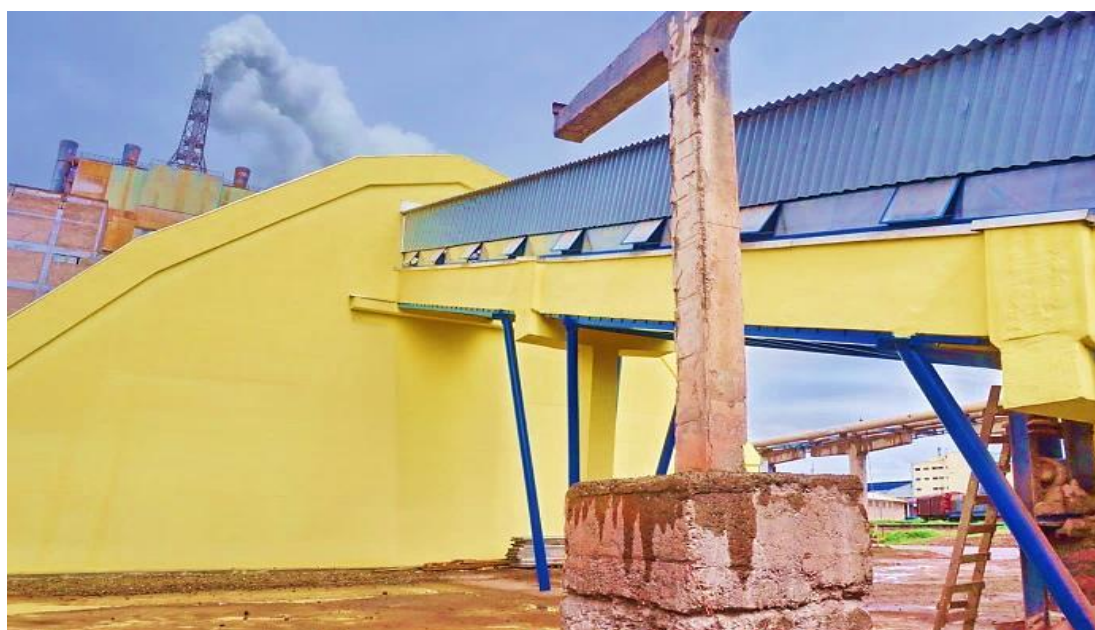
Foto 5.14. Ansamblu estacadă după reabilitare
