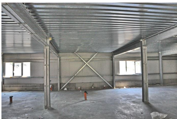
Foto 4.1. Planșeu înainte de consolidare. Vedere travee cadre structură
