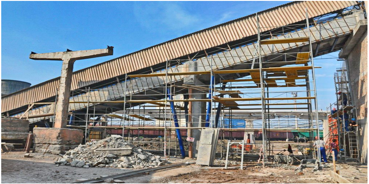
Foto 5.3. Execuție lucrări reabilitare
