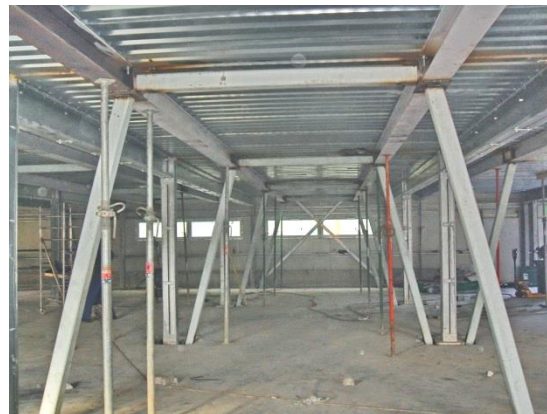
Foto 4.2. Planșeu după dispunerea elementelor de consolidare
