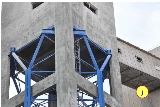
Foto 1.18. Turnul de întoarcere de la complexul industrial Azomureș, Tg. Mureș: detalii ale structurii metalice de susținere a camerei de deviere, realizată sub exploatare (f-j)
