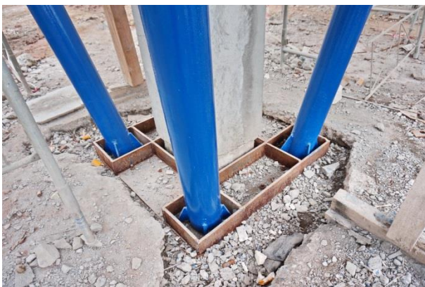
Foto 5.8. Execuție sistem susținere estacadă la rezemarea pe fundație
