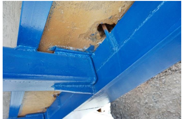
Foto 5.9. Execuție consolidare grinzi
