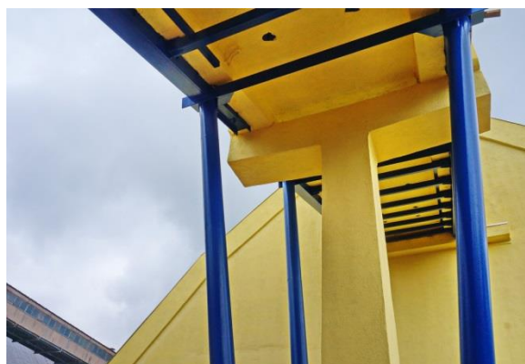
Foto 5.15. Vedere estacadă reabilitată în zona stâlpului
