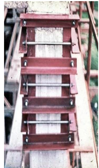
Foto 1.1 (a-d). Soluții utilizate pentru reabilitarea stâlpilor de beton armat, respectiv a nodurilor de cadru
