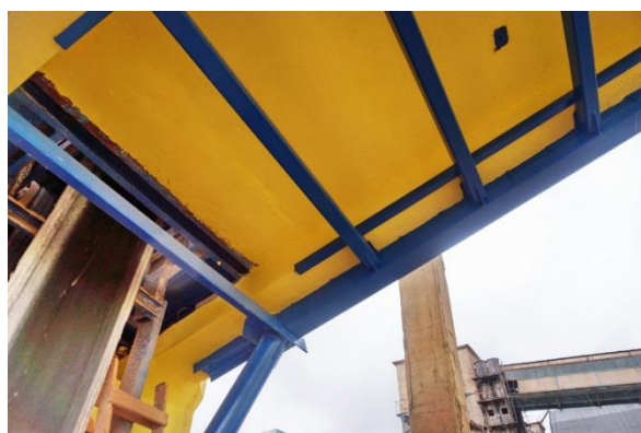
Foto 5.16. Vedere estacadă reabilitată în zona întinzătorului benzii transportoare
