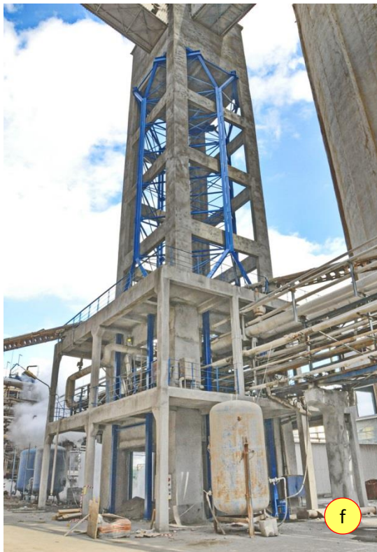
Foto 1.18. Turnul de întoarcere de la complexul industrial Azomureș, Tg. Mureș: situația după consolidare (f-j)
