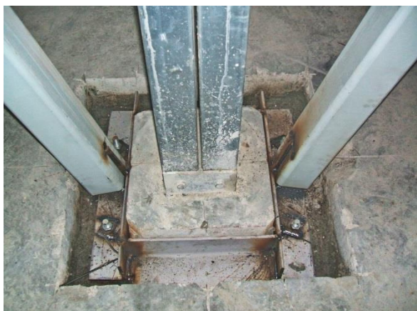
Foto 4.5. Execuție rezemare pe fundație elemente de susținere grinzi consolidare
