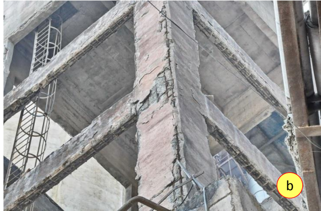
Foto 1.18. Turnul de întoarcere de la complexul industrial Azomureș, Tg. Mureș: starea tehnică inițială (a-e)
