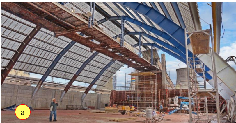
Foto 1.17. Arcele metalice ale structurii depozitului de fosforite de la complexul industrial Azomureș, Târgu Mureș
