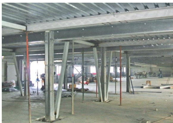
Foto 4.4. Planșeul după dispunerea elementelor de consolidare
