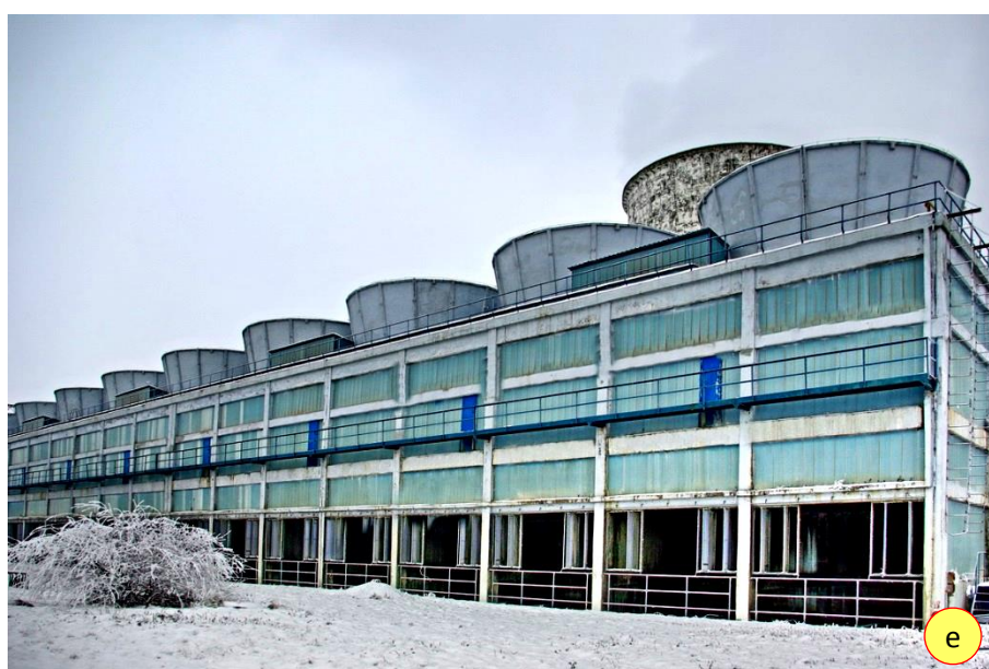
Foto 1.16. Turnul de răcire forțată TRF 3, Iernut: situația după reabilitare (e)
