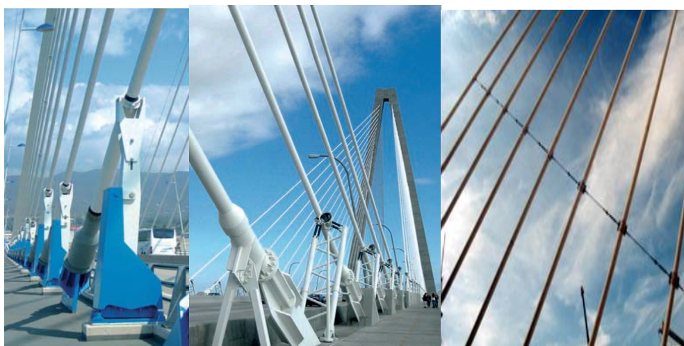
Fig. 101 Accesoriile de amortizare a cablurilor
