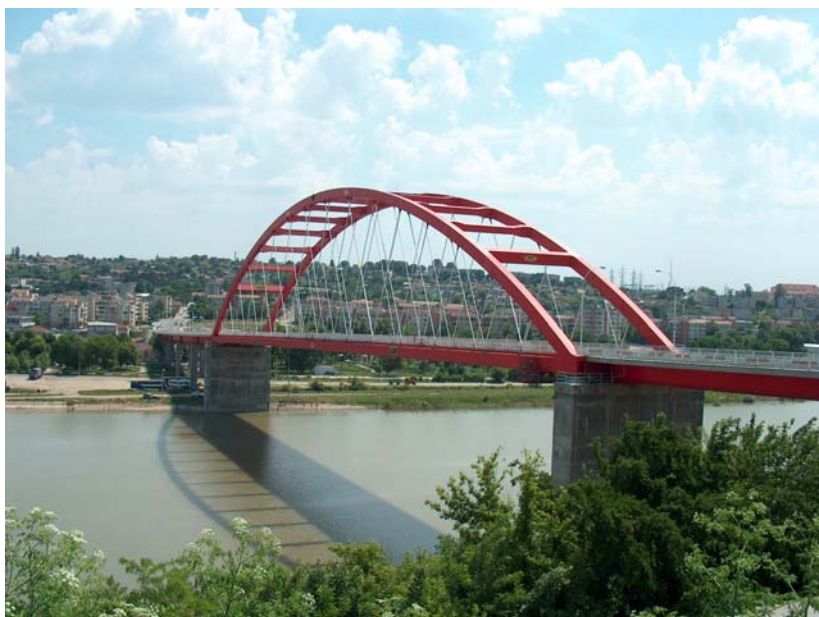
Fig. 57 Podul Sfânta Maria peste canalul Dunăre-Marea Neagră de la Cernavodă - 2002
