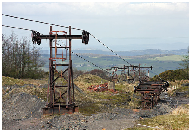
Fig. 73 Stație de unghi
