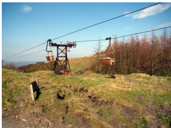
Fig. 69 Piloni scurți pentru funiculare
