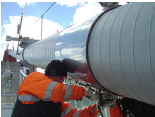
Fig. 104 Aplicarea benzilor din polietilena
