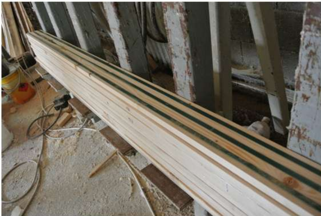
Fig. 4.21- Dispunerea armăturilor din bandă PET, câte trei
