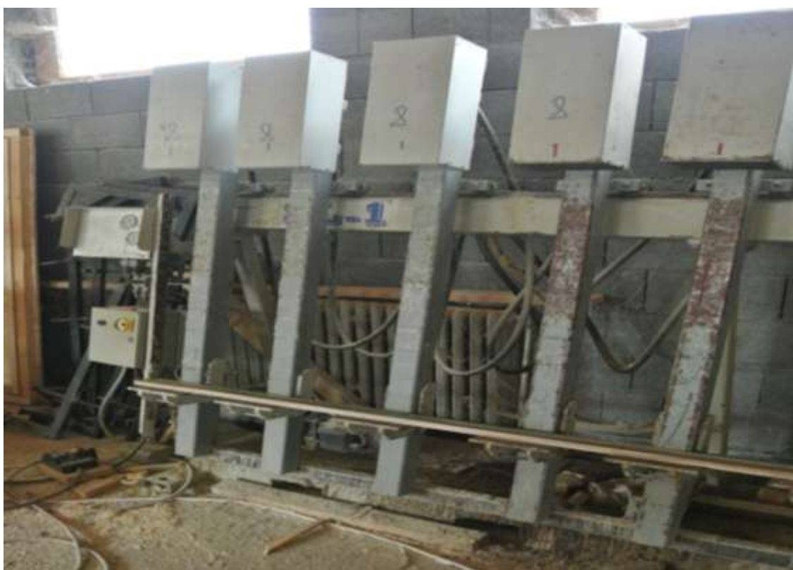
Fig. 4.18- Începerea dispunerii lamellelor în presa hidraulică
