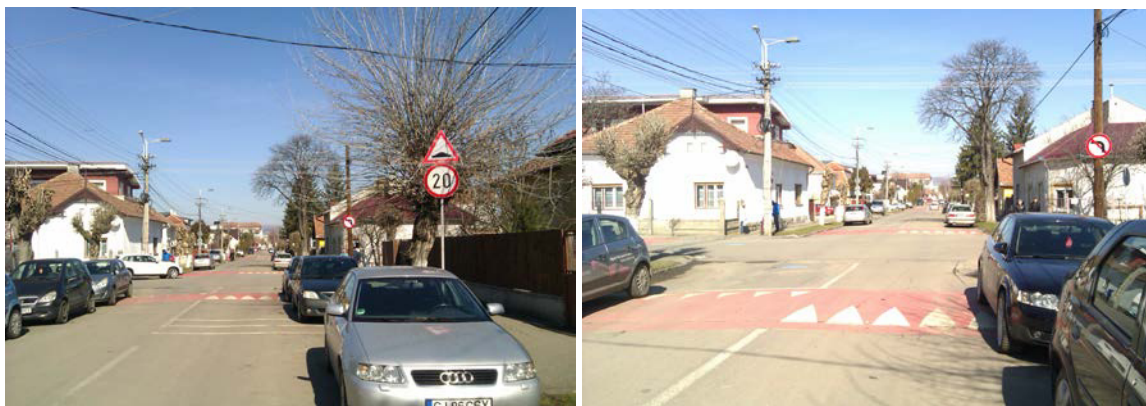
Figura 3.27. Aspect praguri de viteză str. Arieșului
