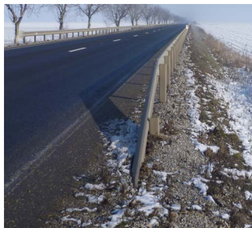
Figura 3.1. Capăt parapet îngropat
