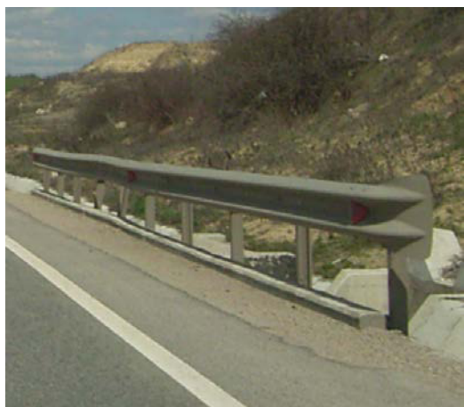
Figura 3.1. Capăt parapet îngropat
