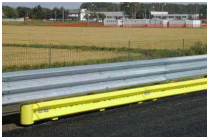
Figura 3.7. Element continuu pentru protecția motocicliștilor [126]
