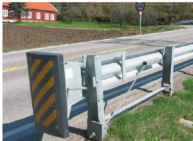
Figura 3.3. Capăt parapet cu element tampon
