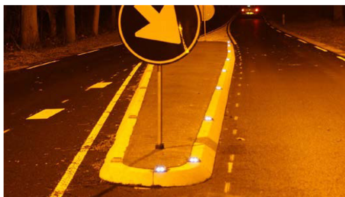
Figura 3.14. Insulă marcată și semnalizată cu butoni reflectorizanți
