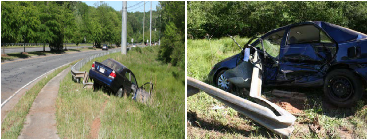
Figura 3.2. Capăt de parapet provocator de accident
